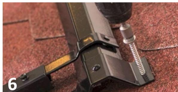
Skru fast skinnen i taket med to skruer 6,3x65mm. Skruene skal treffe mest mulig midt på tak-sperrene. Husk pakning mellom skinnen og taket
