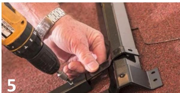
Fest øvre innfestestag til den øverste stige-modulen med den ferdig påmonterte skruen (skru opp, tilpass og skru fast) og tilpass innfesteskinnen til stige og stag .
