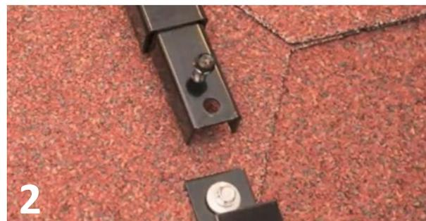
Monter første stigemodul i de nedre festebrakettene ved å demontere skruen på skjøtelasken, skyve lasken inn i braketten og monter skruen igjen.
