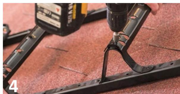
Modulene skjøtes sammen som den første, demonter skruen, skyv lasken inn i stige-vangen, skru igjen og monter tverrtrinn. Stopp før siste modul.
