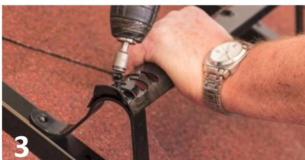
Monter tverrtrinnene over de påmonterte skruene i stigevangene (NB! Materialforskyvningen skal synes i det store hullet), og skru godt fast.
