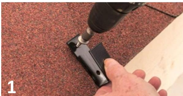
Monter de nedre innfestebrakettene slik at de kommer mellom to taksperre. Husk å sette på pakning mellom brakett og tak. Fest hver av brakettene med skruer 6,5x38mm.
